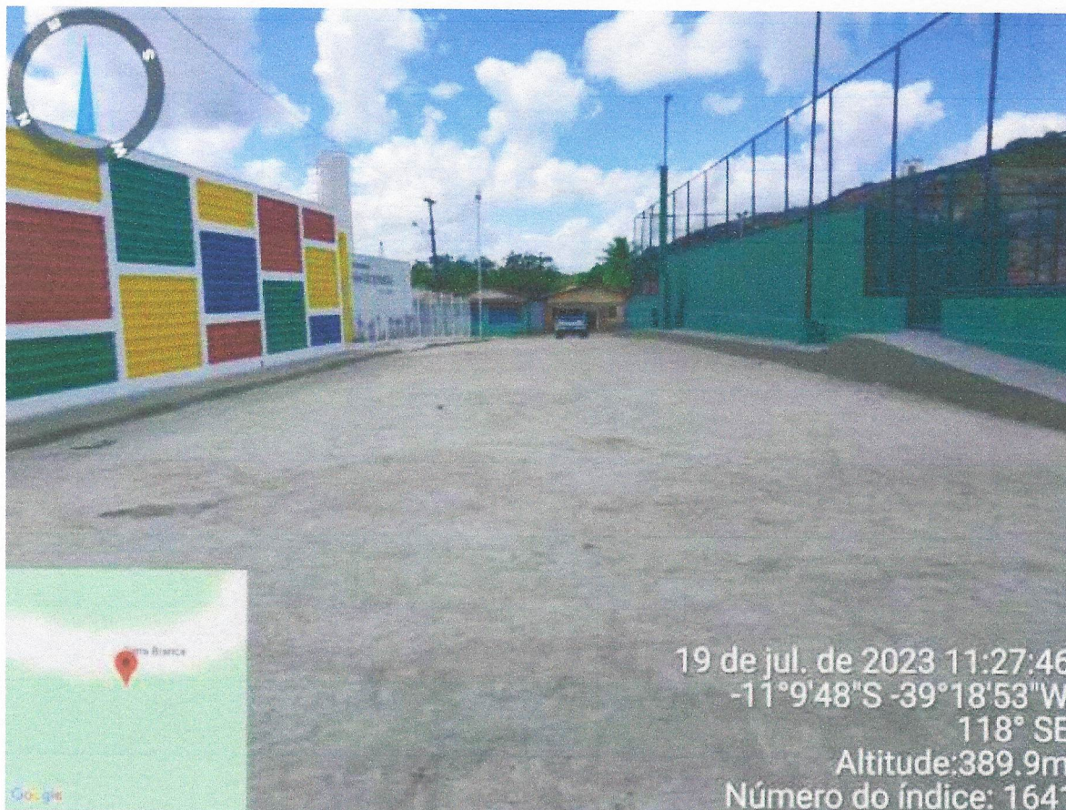
Complementação de pavimento na Rua saída para Santana/povoado
