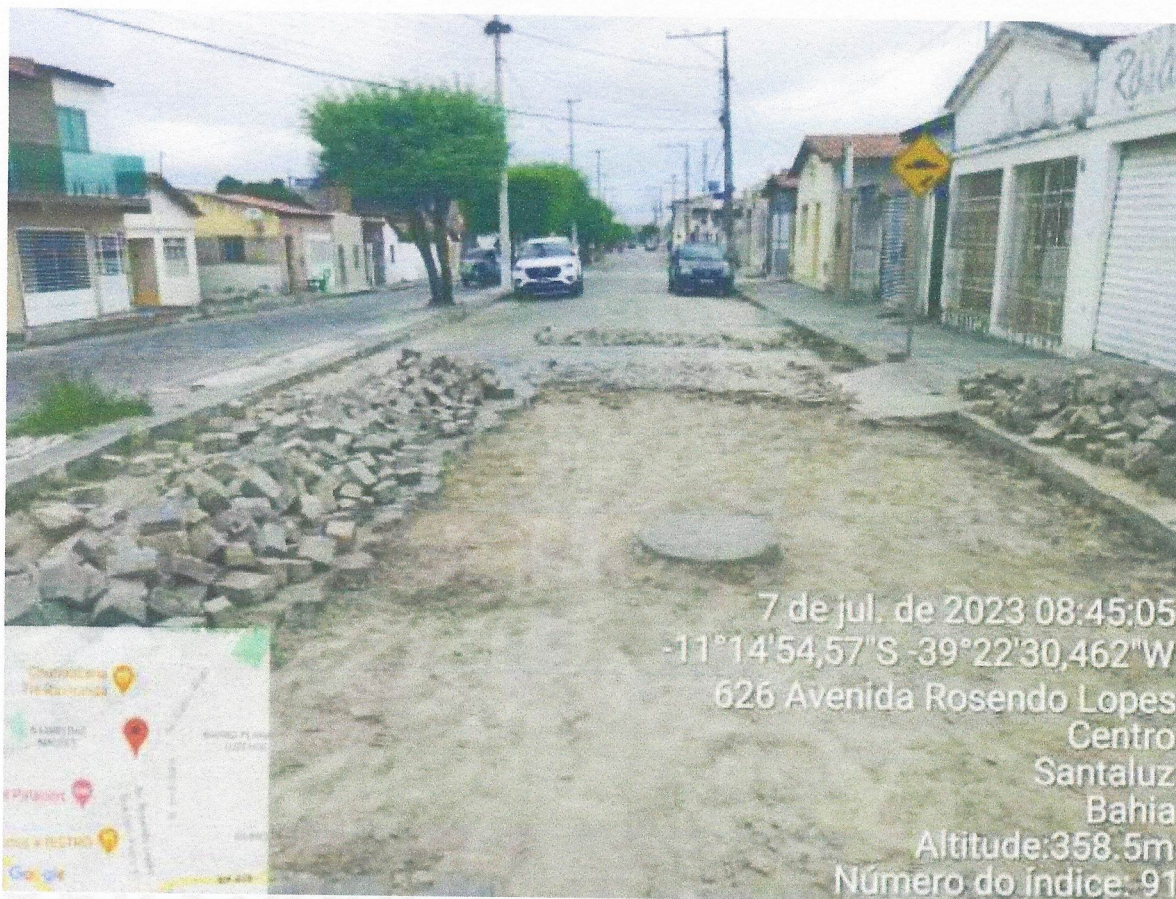
Recuperação da Pavimentação em Paralelo na AV Rosendo Lopes/Sede
