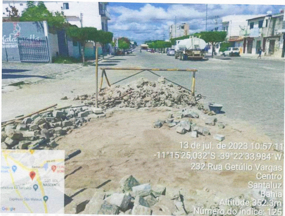
Recuperação da Pavimentação em Paralelo na Rua Getúlio Vargas/Sede
