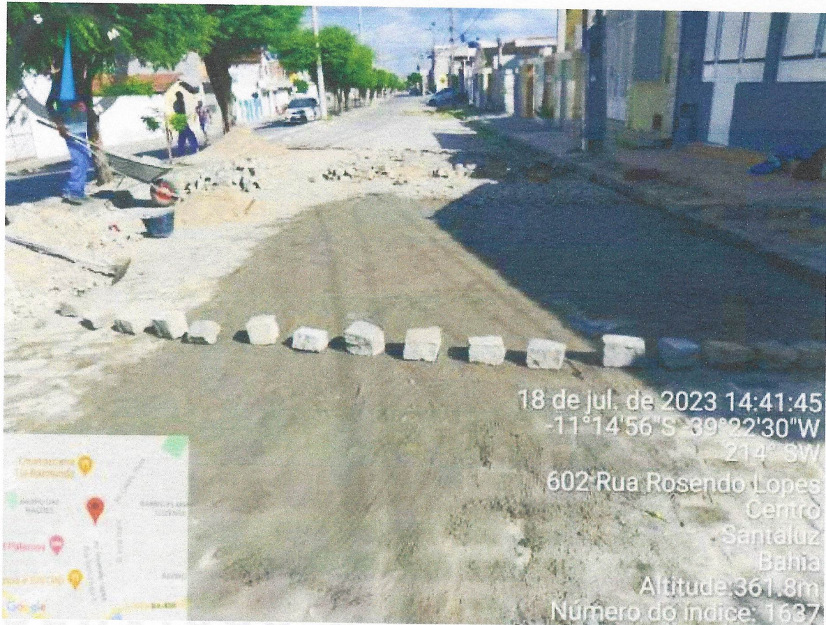
Recuperação da Pavimentação em Paralelo na AV Rosendo Lopes/Sede
