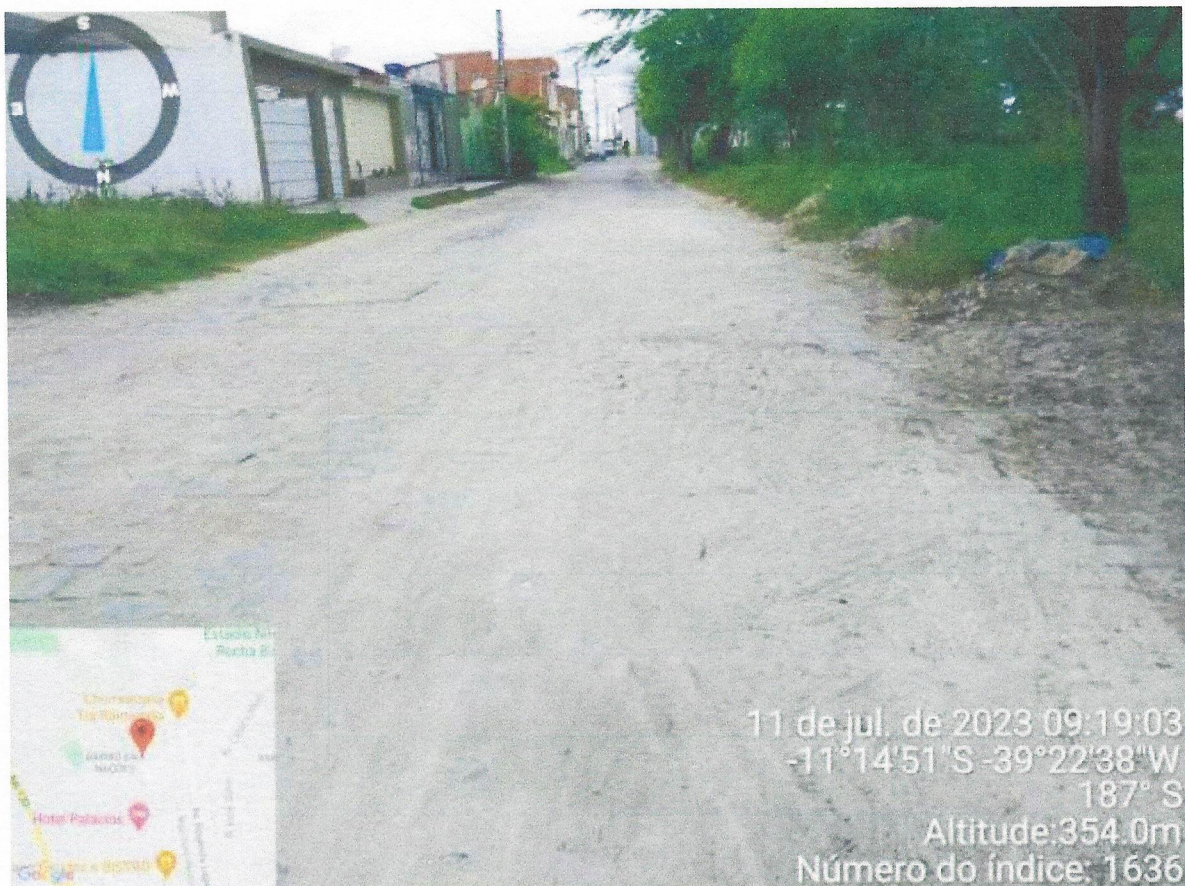
Recuperação de Pavimentação em Paralelo na Rua J.J Seabra/Sede
