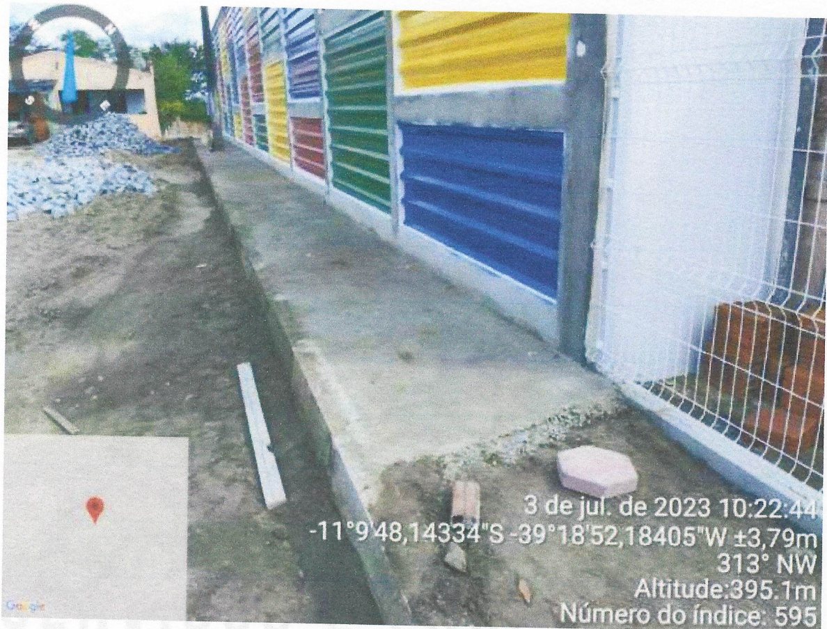
Complementação de pavimento na Rua saída para Santana/povoado
